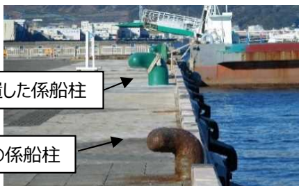
係船柱の整備事例
